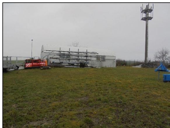
Abb. 3: Halle und Funkmast im nordöstlichen Plangebiet.
