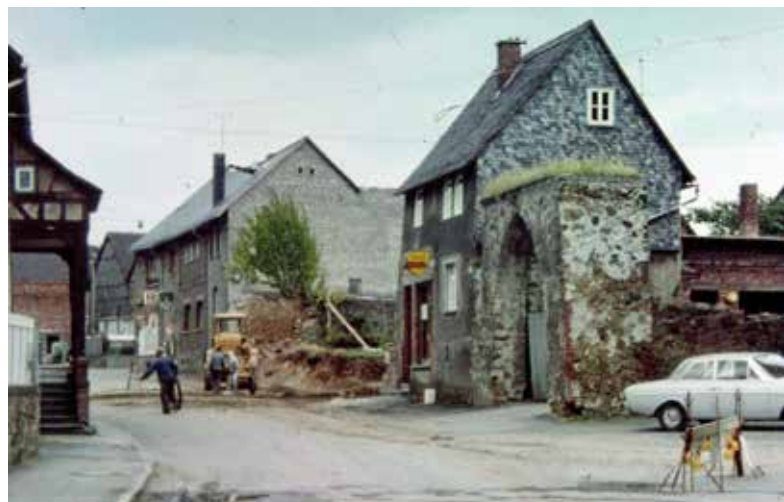
Wetzlarer Straße um 1970 mit Baustelle Kirchhofsmauer
