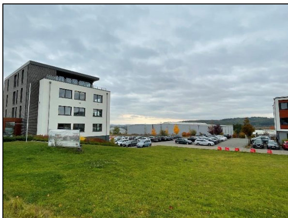
Abb. 5: Blick auf die Fläche in Blickrichtung Südosten und auf das Gebäude der Firma Revikon
